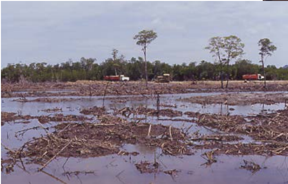
フィジーでのホテル建設用地)
